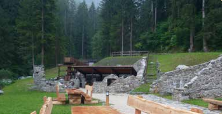
L'OPIFICIO AZIONATO DALL'ENERGIA DELL'ACQUA
