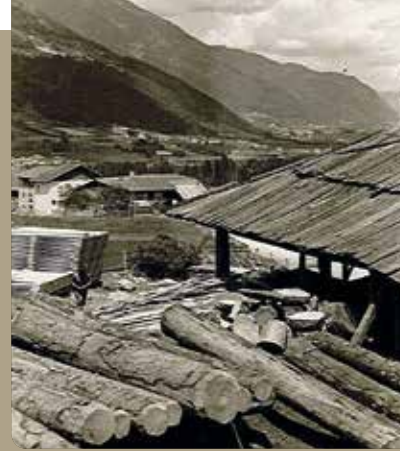
LA VECCHIA SEGHERIA PRIMA DELL'ABBATTIMENTO PER LA RICOSTRUZIONE
